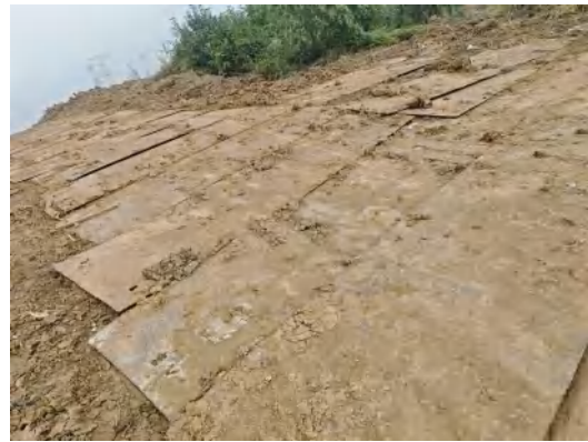
临时施工道路铺设钢板
