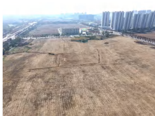
拆除塔基基础建筑垃圾及时清运
