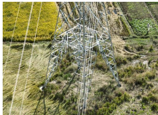
塔基生态恢复
