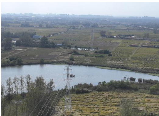
线路跨越乌龙冲水库
