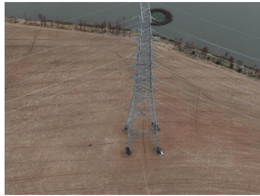
塔基生态恢复
