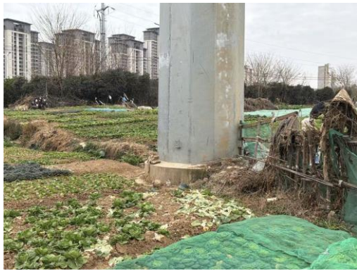
塔基生态恢复
