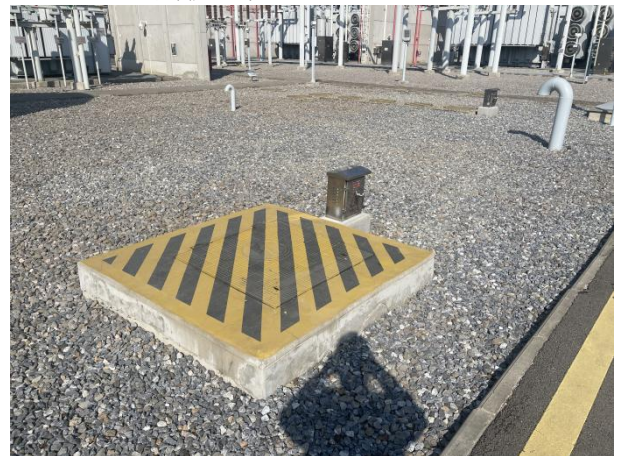
主变事故油池
