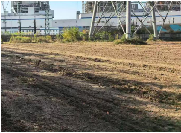
施工道路土地整治
