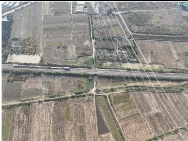
4#-5#跨越场区域植被恢复
