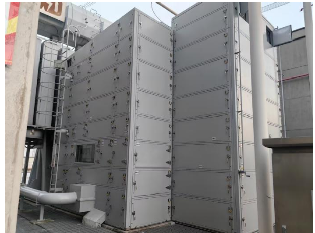
高压电抗器可拆卸声振解耦吸声板
