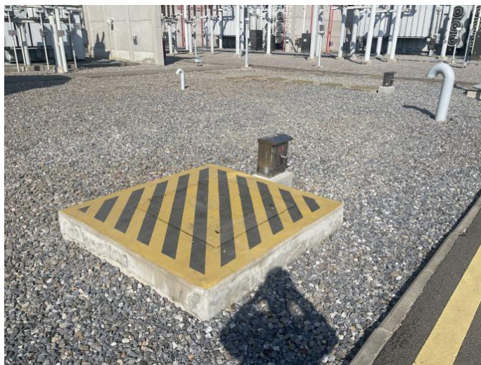
图 11.2-1 淮南 1000kV 变电站主变事故油池
