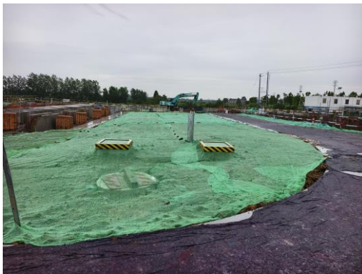
裸露地面苫盖
