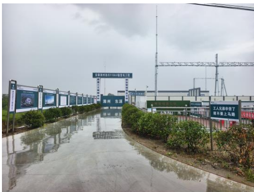
施工道路硬化
