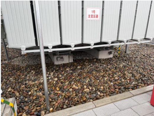
主变下方铺设卵石层
